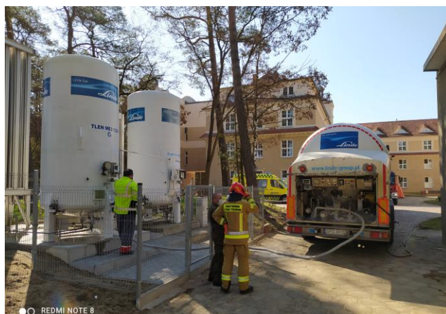
Zdjęcie nr 17 Zbiornik na tlen medyczny o pojemności 3000 l wraz z parownicą o wydajności 260m 3 /h
