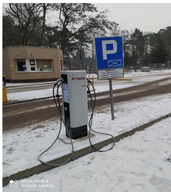
Zdjęcie nr 16 Stacja ładowania pojazdów elektrycznych o mocy 2x22kW
